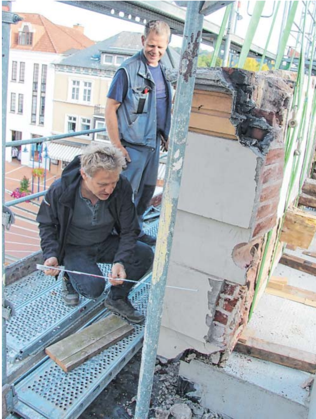
Passt: Architekt Franz Janssen (links) prüft den richtigen Abstand des Wappen-Frieses an seinem neuen Standort. Mark Schürmann vom Fachbetrieb Wistinghausen schaut ihm zu. FOTO: WOLFGANG BECKER
